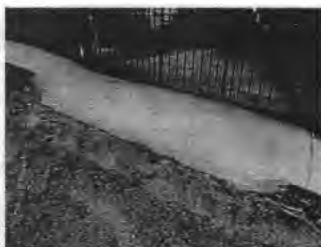
Fotografía N° 1: Vista de un acceso vehicular sin juntas de dilatación en toda su superficie y bordes.
