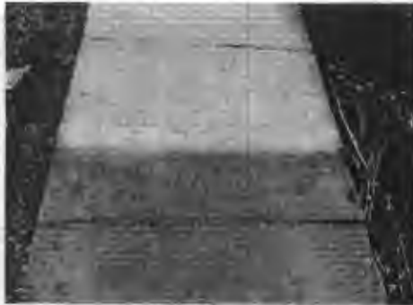
Fotografía N° 3: Encuentro de hormigones de distintas edades desprovisto de la junta de hormigonado.
