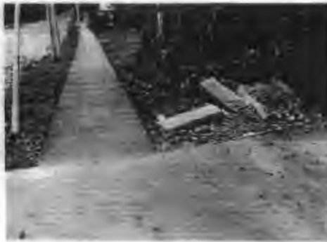
Fotografía N° 8: Ilustración de los restos de soleras existentes contiguos al radier de estacionamiento.
